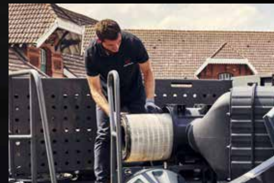
Könnyű hozzáférés a levegőszűrő ellenőrzése és tisztítása céljából
